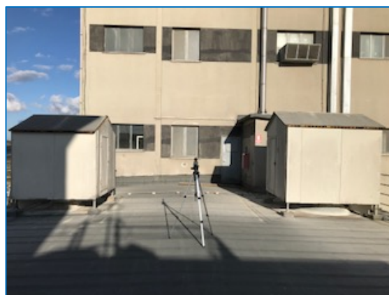
Aspiratori insonorizzati tramite apposite cabine fonosilenti.
