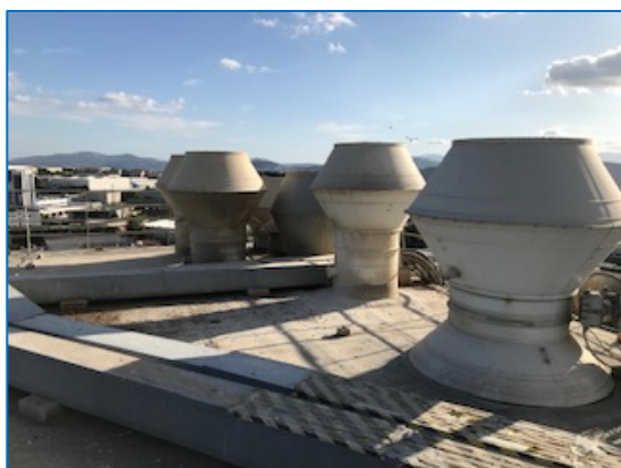
Aspiratori posti in copertura, a circa 40 m di altezza.
